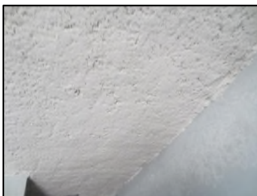
Photo N° 610 ECH-N°2 FLOCAGE -- LOCAL VELO Plafonds Blanc cotonneux
